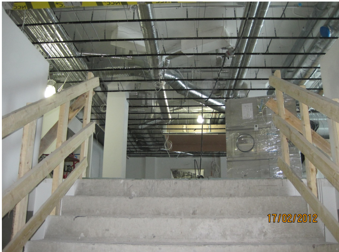
2. kerroksen ravintolan alakattorungot asennettu.
