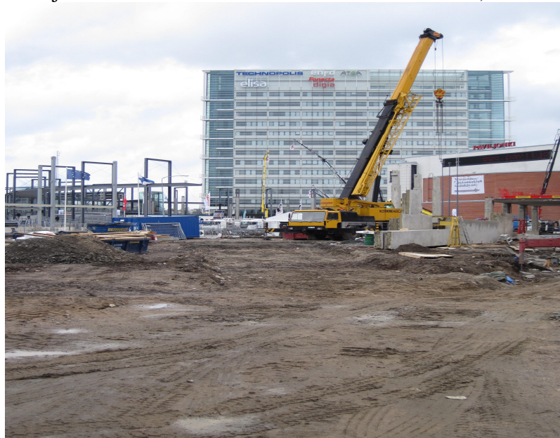
Kunnallistekniikan reitti työmaan läpi (Uno Savolan kadulta).
